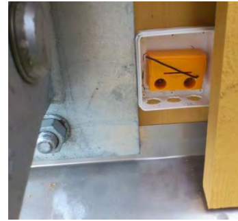
Figure 5: Moisture sensor on pylon (D)
